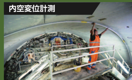
内空変位計測 内壁に設置することで、トンネルや下水管などの内空変位の計測が可能です。
