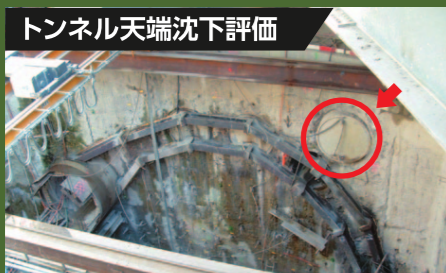
トンネル天端沈下評価 トンネル天端に水平に設置することで、掘削時の天端沈下計測が可能です。
